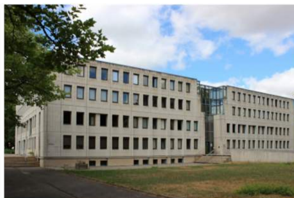
Bâtiment de la DDT - Bar-le-Duc
